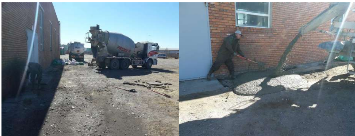
Бетондож буй ажлын явц
