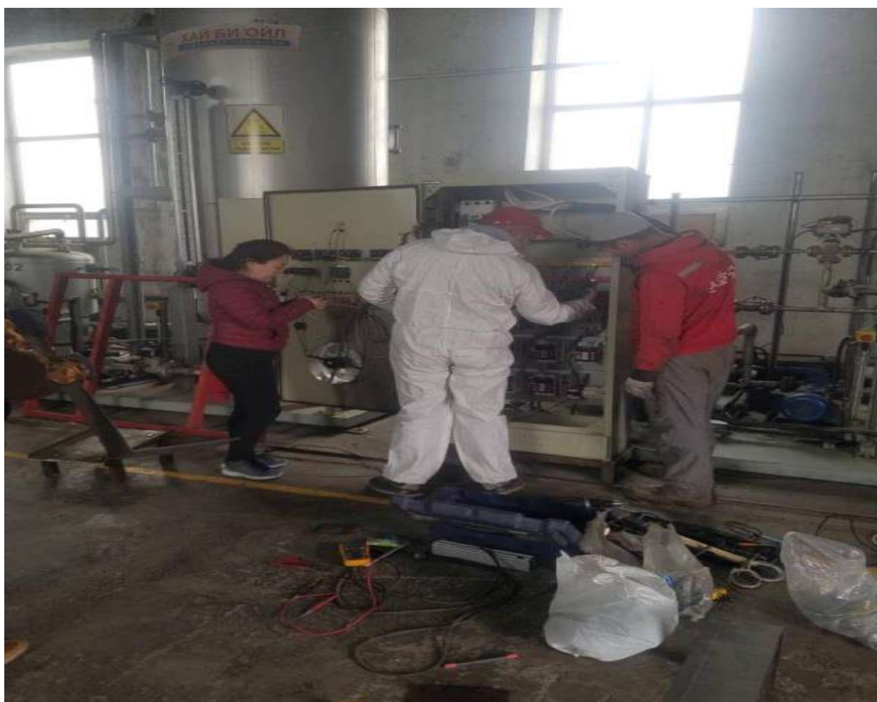
Тос халаагч тогоогоо суурилуулж, цахилгаантай холболт хийж бэлэн болгов.
