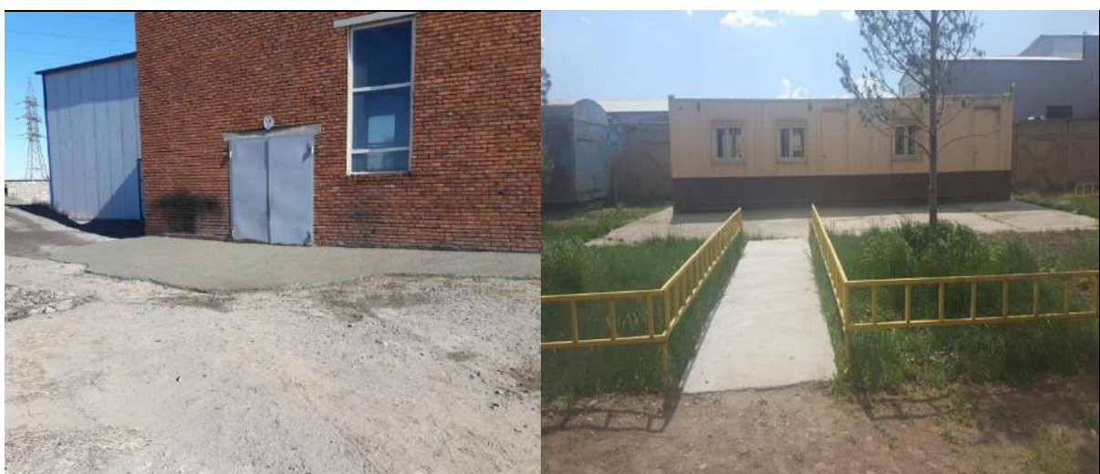
Бетондсоны дараах байдал
