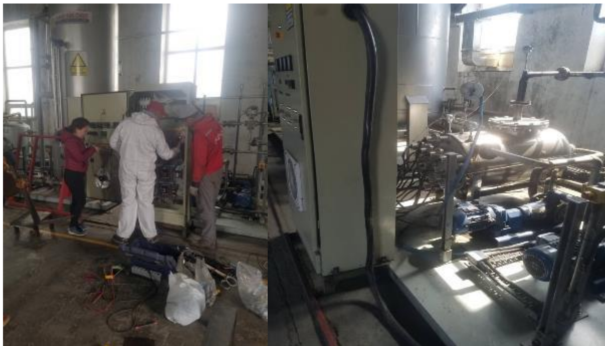
Тос халаагч тогоогоо суурилуулж, цахилгаантай холболт хийж бэлэн болгов.
