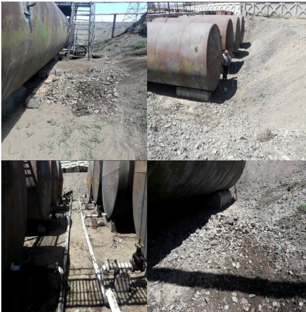
Агуулахын суурийг цэвэрлэж тэгшлэж байгаа нь
