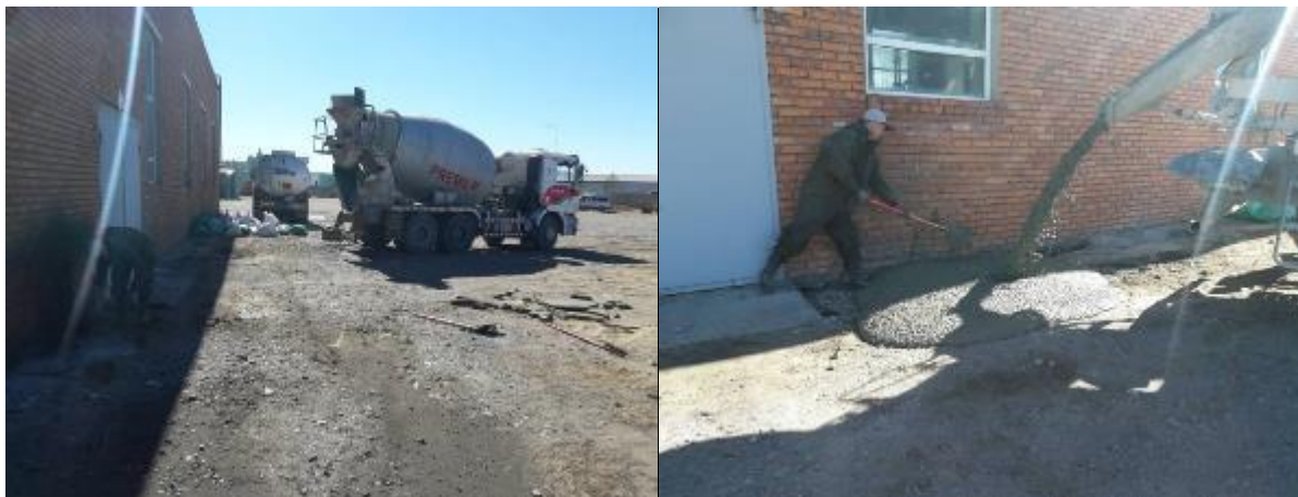
Бетондож буй ажлын явц
