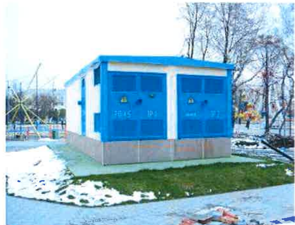
10/0,4кВ-н 2х1250кВА уламжлалт дэд өртөөнөөс 3 дахин бага зай талбай эзэлдэг БИОСКО-Б120Т дэд өртөө
