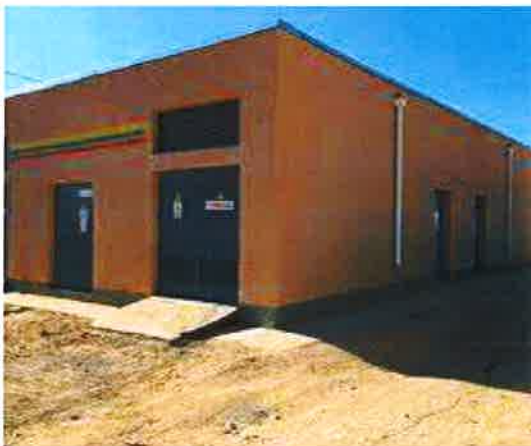
10/0,4кВ-н 2х1250кВА уламжлалт дэд өртөө
