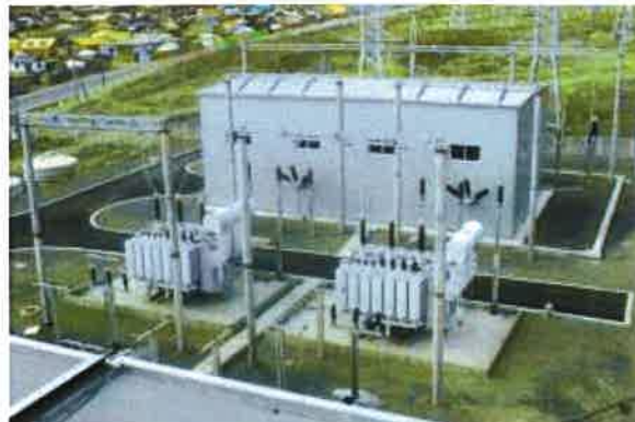
Уламжлалт 110/35/10кВ-н 2х40МВА-н дэд өртөөнөөс 3-4 дахин бага зай талбай бага эзэлдэг GIS дэд өртөө
