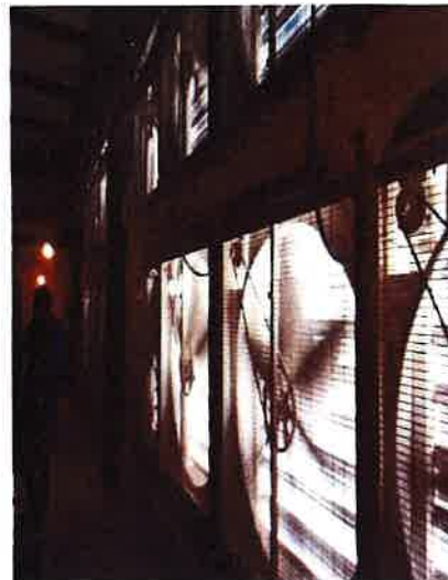
Өндөглөгчийн байрны агааржуулалтын систем, өндөг дөмжуулагч
