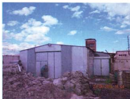
Цилиндр шугам хоолойн үйлдвэрийн барилга
